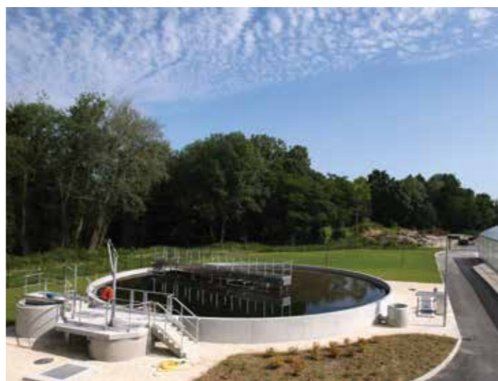
Station d'épuration au Châtelet-en-Brie
