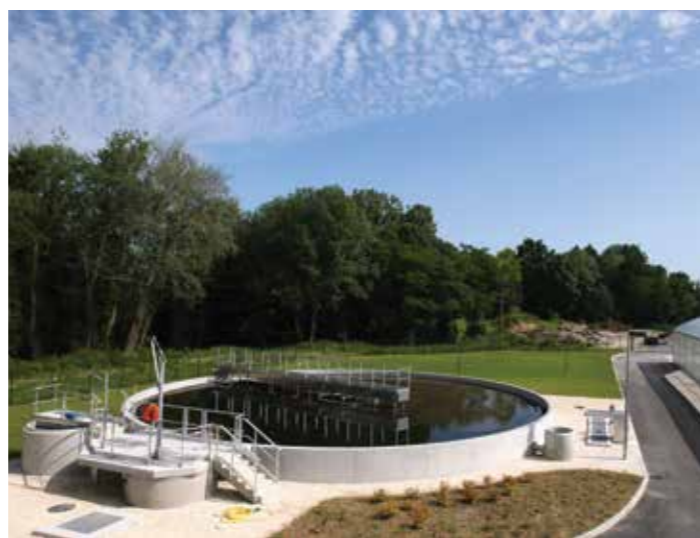
Station d'épuration au Châtelet-en-Brie
