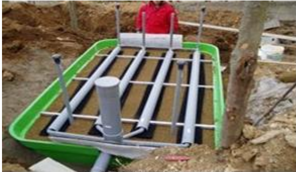
Travaux d'installation d'un filtre à zéolite
