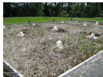
Filtre planté de roseaux en phase d'alimentation
