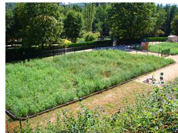
Filtre planté de roseaux en phase d'alimentation
