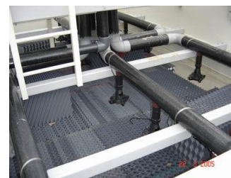
Système de répartition de l'effluent
