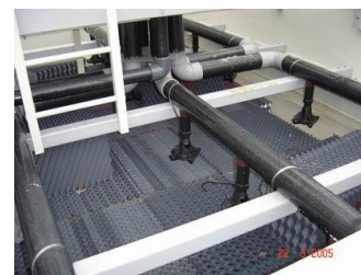
Système de répartition de l'effluent
