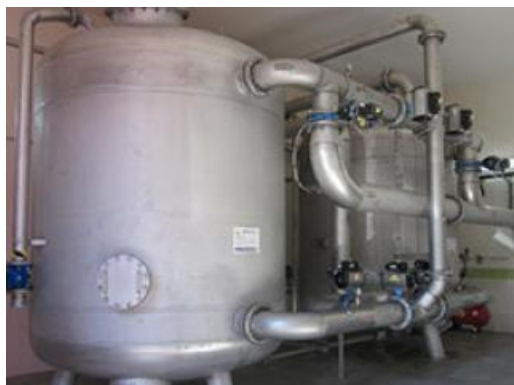
Unité de traitement des pesticides au charbon actif du captage de Bagneaux-sur-Loing. ©LAURENCE VIÉ/SEPOMA/CD77
