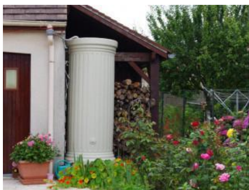
Cuve de récupération des eaux pluviales. ©STÉPHANIE HAMON
