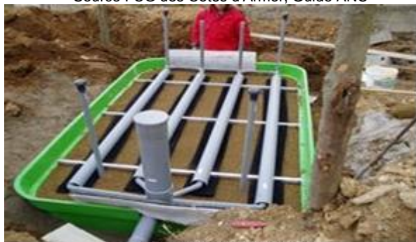
Travaux d'installation d'un filtre à zéolite
