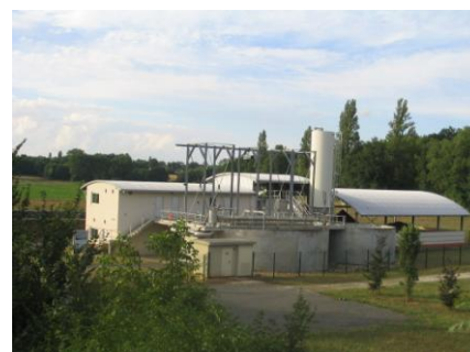
Filtration membranaire de Perthes-en-Gâtinais
