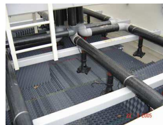
Système de répartition de l'effluent
