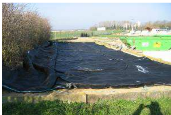
Poche en cours d'installation
