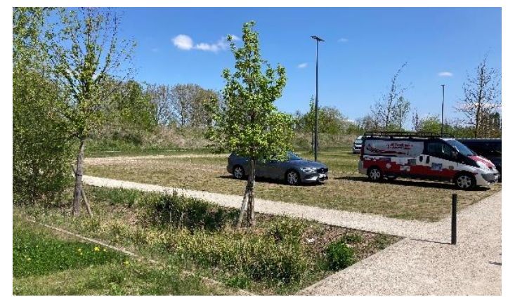
Parking perméable + noue, Vaires-sur-Marne
