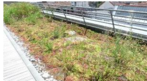
Toitures végétalisées (>8cm)
