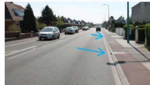
Massifs infiltrant alimentés par canalisations
