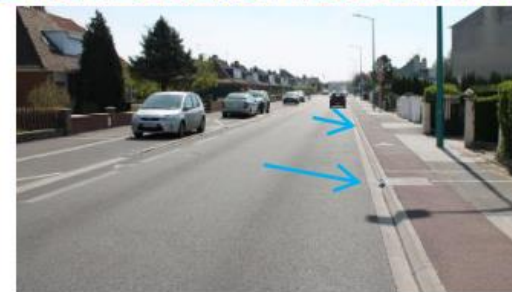
Massifs infiltrant alimentés par canalisations
