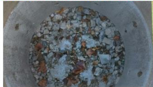
Puits d'infiltrations
