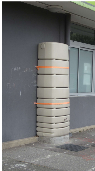
Citerne de récupération
