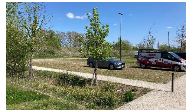
Parking perméable + noue, Vaires-sur-Marne
