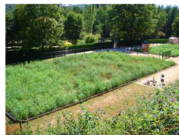
Filtre planté de roseaux en phase d'alimentation
