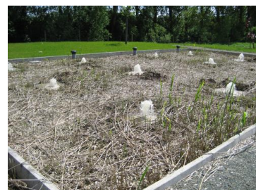
Filtre planté de roseaux en phase d'alimentation
