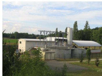
Filtration membranaire de Perthes-en-Gâtinais
