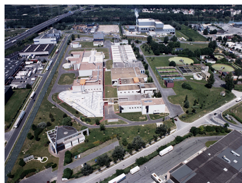
Biofiltration de Saint-Thibault-des-Vignes (350 000 EH)
