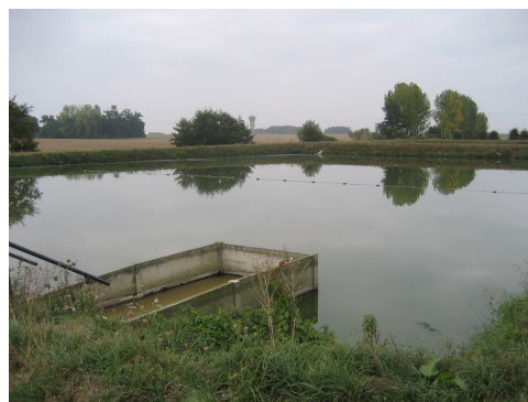
Lagunage de Chevru (600 EH)
