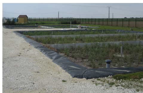
Filtre planté de roseaux de Cerneux (250 EH)
