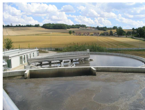
Boues activées de Provins (23 330 EH)
