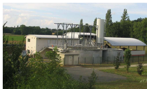
Filtration membranaire de Perthes-en-Gâtinais (4 500 EH)
