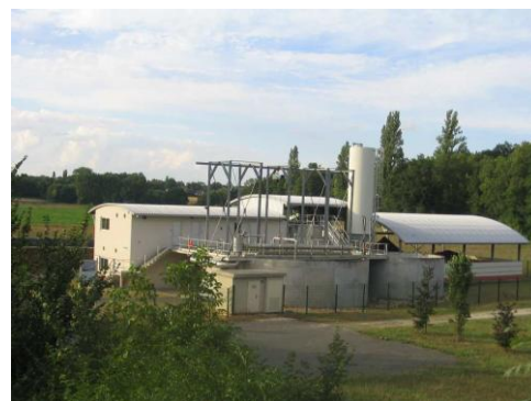
Filtration membranaire Perthes-en-Gâtinais (4 500 EH)
