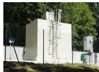
Système de répartition de l'effluent
