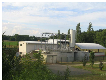
Filtration membranaire de Perthes-en-Gâtinais
