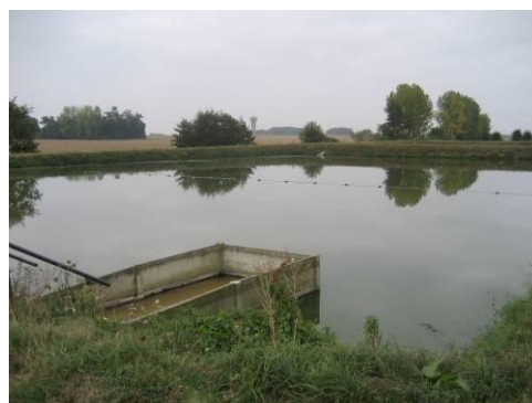
Lagunage - Chevru (600 EH)
