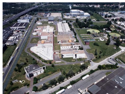
Biofiltration Saint-Thibault-des-Vignes (350 000 EH)
