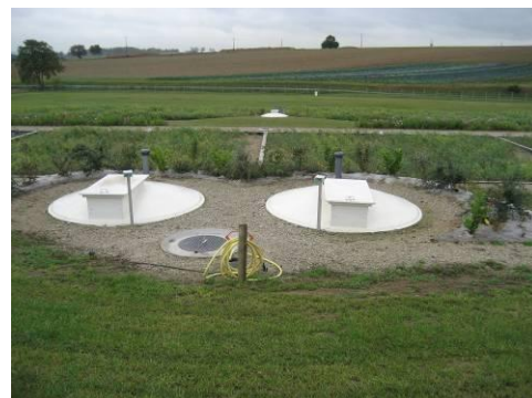
Filtre planté de roseaux Chambry (1 200 EH)
