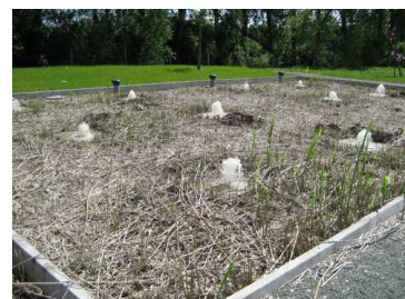
Filtre planté de roseaux en phase d'alimentation
