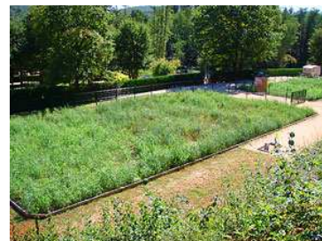
Filtre planté de roseaux en phase d'alimentation
