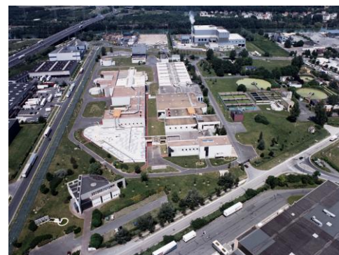
Biofiltration Saint-Thibault-des-Vignes (350 000 EH)
