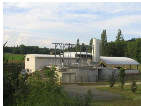
Filtration membranaire Perthes-en-Gâtinais (4 500 EH)
