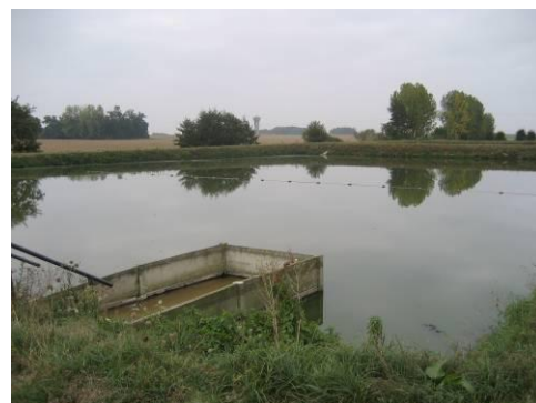
Lagunage - Chevru (600 EH)
