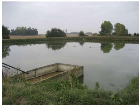
Lagunage - Chevru (600 EH)
