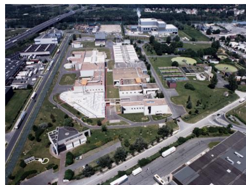
Biofiltration Saint-Thibault-des-Vignes (350 000 EH)
