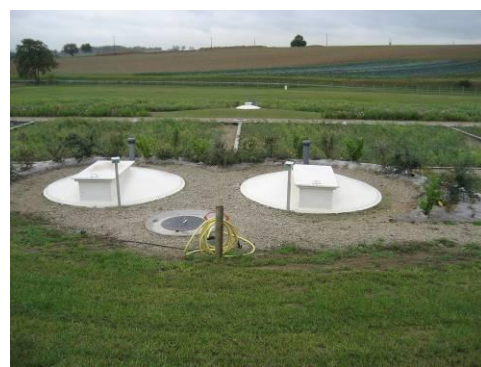
Filtre planté de roseaux Chambry (1 200 EH)
