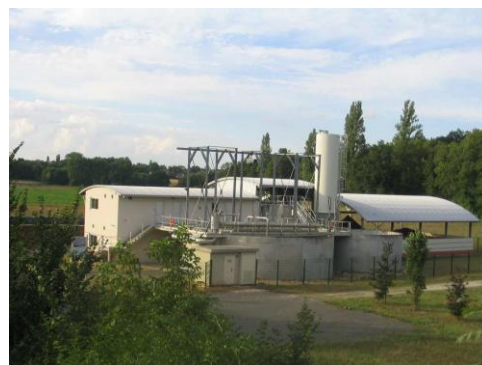
Filtration membranaire Perthes-en-Gâtinais (4 500 EH)
