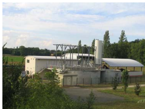
Filtration membranaire Perthes-en-Gâtinais (4 500 EH)
