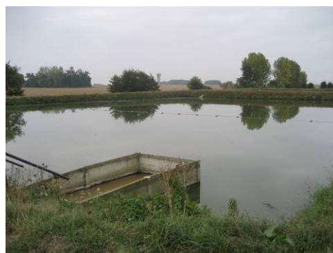
Lagunage - Chevru (600 EH)
