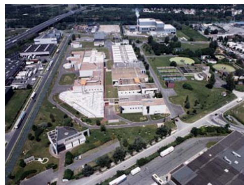
Biofiltration Saint-Thibault-des-Vignes (350 000 EH)
