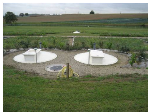
Filtre planté de roseaux Chambry (1 200 EH)
