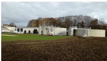
Station d'épuration de Coubert (2018) Capacité épuratoire de 3 400 EH
