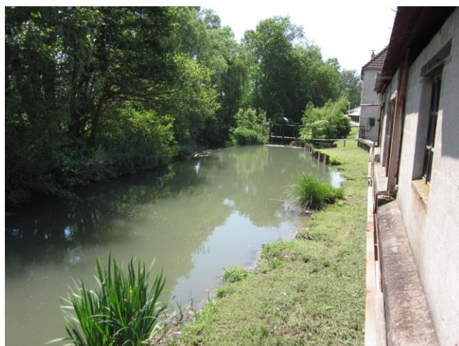
La Voulzie à Longpont : avant travaux
