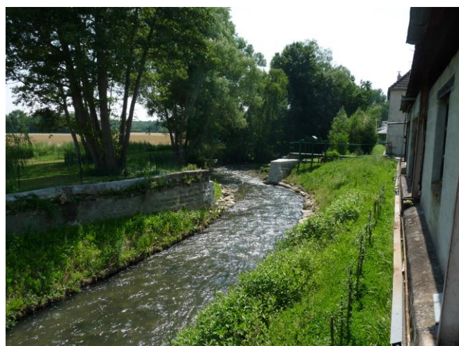
La Voulzie à Longpont : après travaux
