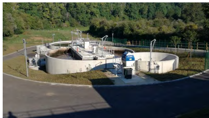
Station d'épuration de Machault dite « PAMAVAL » (Boues activées-3100 Equivalents-Habitants – mise en eau juin 2021) – source SATESE
