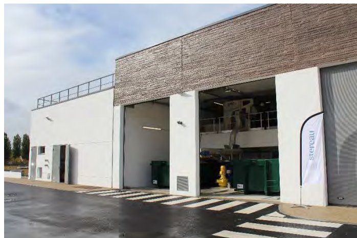
Mise en service en 2022 de la nouvelle unité de traitement des eaux à Coulommiers
