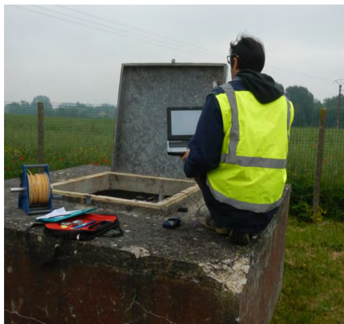
Contrôle du niveau de la nappe du Champigny enregistré au piézomètre de Voinsles par AQUI'Brie
