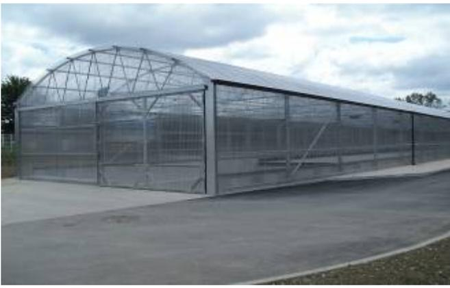
Exemple de traitement des boues par séchage solaire
