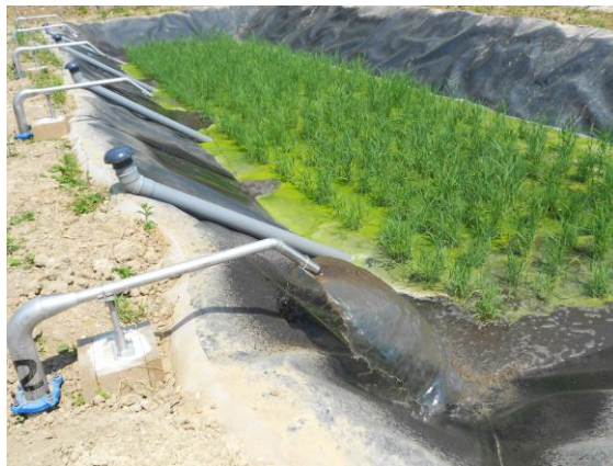
Lit planté de roseaux avec géomembrane
