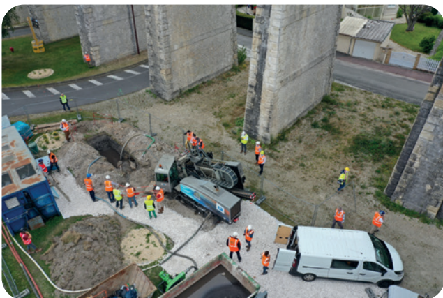
Travaux Transpr'Eauvinois Voulzie Longueville - © S2E77
