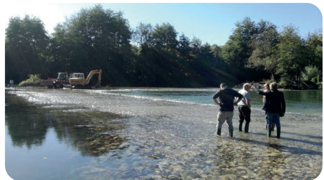
Travaux de restauration du Loing - © CD77
