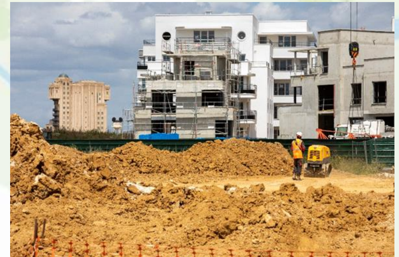
Chantier - ZAC des Studios et Congrès
