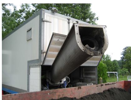
Unité mobile de déshydratation des boues (Intervention sur les boues de lagunage de Meigneux)
