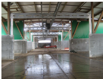
Stockage de boues solides dans un bâtiment fermé (STEP de Villenoy de la CA du Pays de Meaux)
