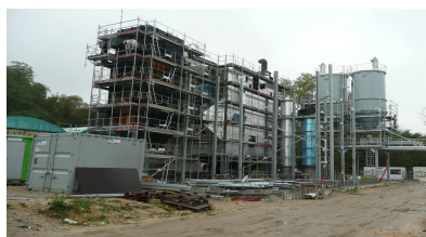
Destruction des boues par incinération (STEP de Dammarie-Les-Lys de la CAMVS)
