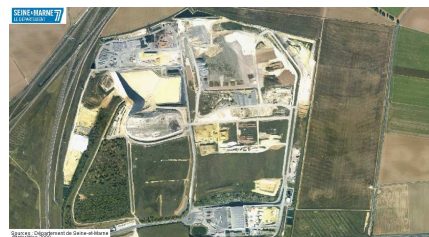
Mise en décharge (REP de Claye-Souilly)
