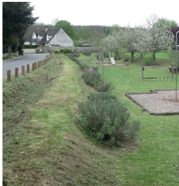
Fossé recueillant les eaux de ruissellement de la voirie, débouchant dans la mare tampon du village. En cas de saturation, le fossé est connecté par une surverse à une aire de jeux inondable ; commune de Prunay-sur-Essonne
