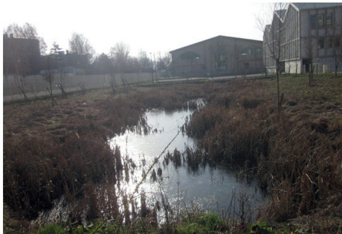
En raison de la présence d'une nappe d'eau peu profonde, les bassins du collège Simone Veil à Chelles sont conçus pour favoriser l'évaporation et l'absorption par la végétation ;
