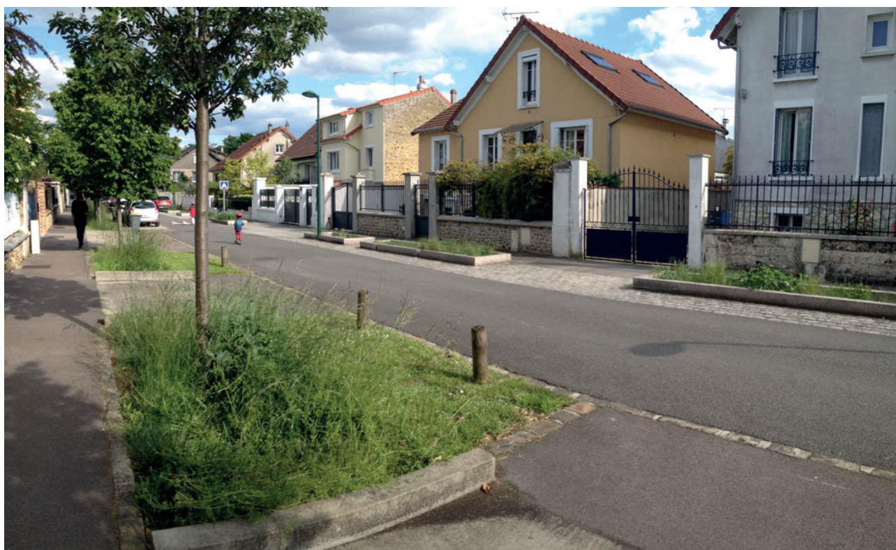
Zones d'infiltration, avenue du Château, Vaires-sur-Marne ; Photo Syndicat Marne Vive
