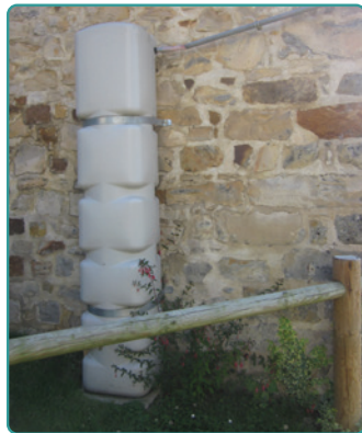
Cuve de récupération des eaux pluviales
