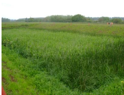
Filtres plantés de roseaux La-Brosse-Montceaux
