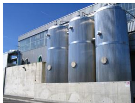
Cuves de stockage des graisses Bonneuil-en-France
