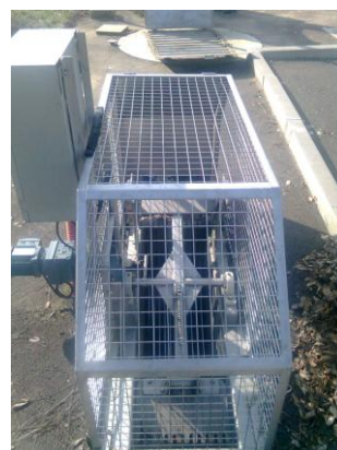
Dégrilleur courbe automatique et capoté Marchemoret
