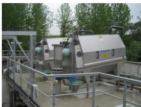
Tamis rotatifs placés à l'extérieur Claye-Souilly
