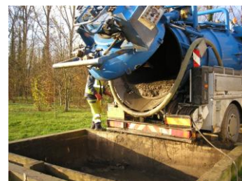
Bac de décantation Provins
