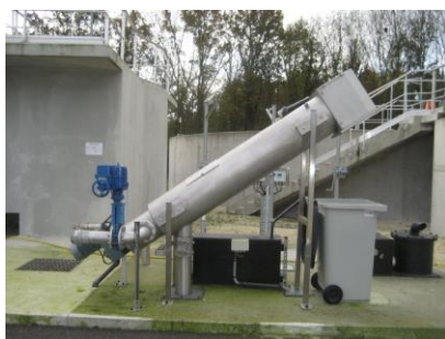
Dégrilleur rotatif Le-Chatelet-en-Brie
