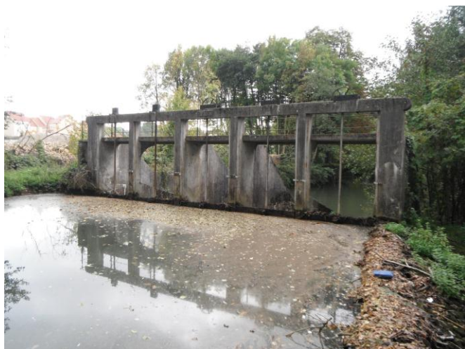
Le Grand Morin au Moulin du Pont : avant travaux
