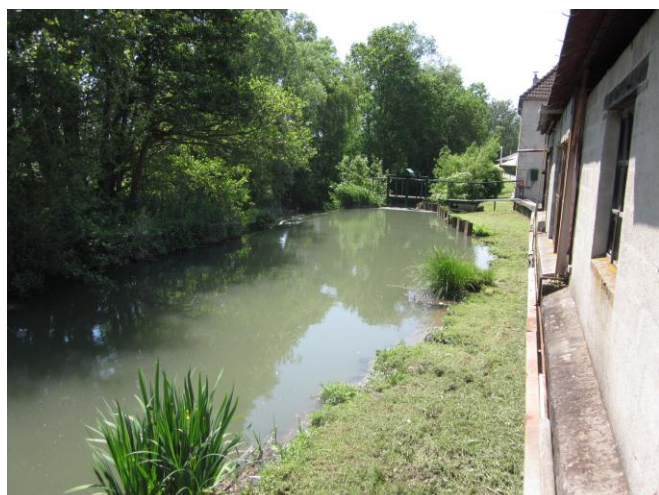
La Voulzie à Longpont : avant travaux
