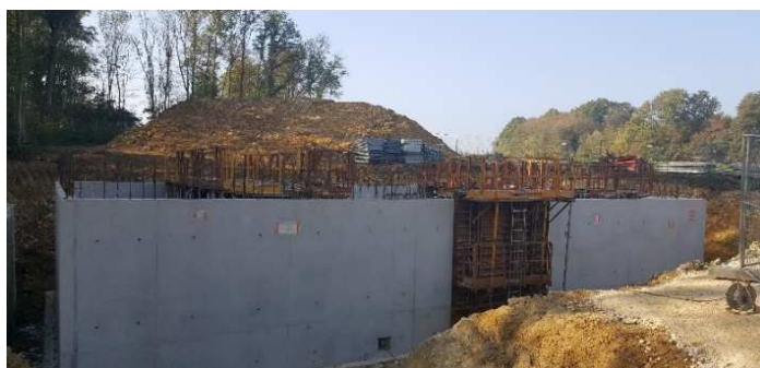
Travaux de construction de l'usine de traitement des pesticides de Verdelot (SNE77 aujourd'hui S2E77)
