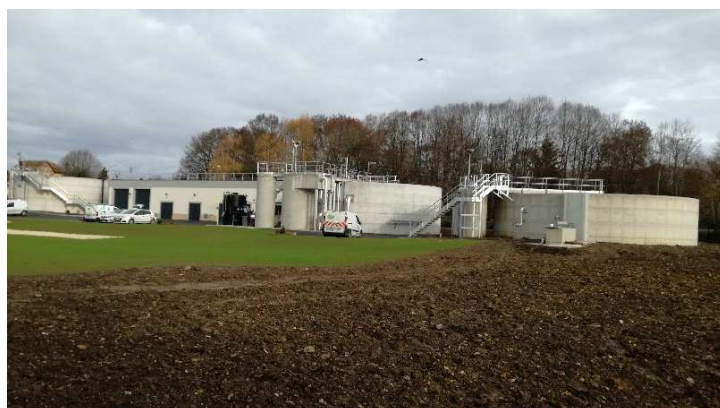
Station d'épuration de Coubert
