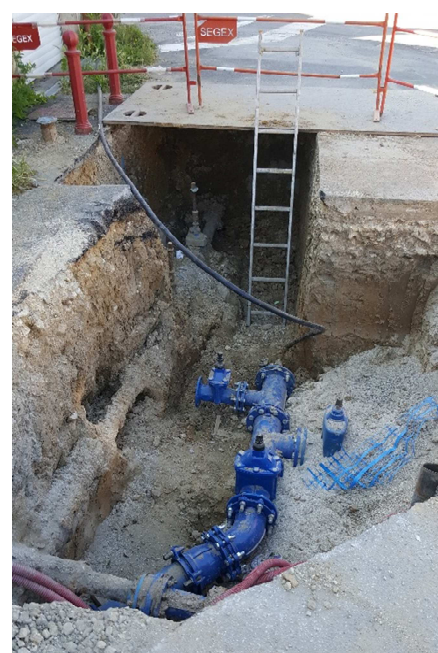
Travaux de renouvellement de canalisation AEP
