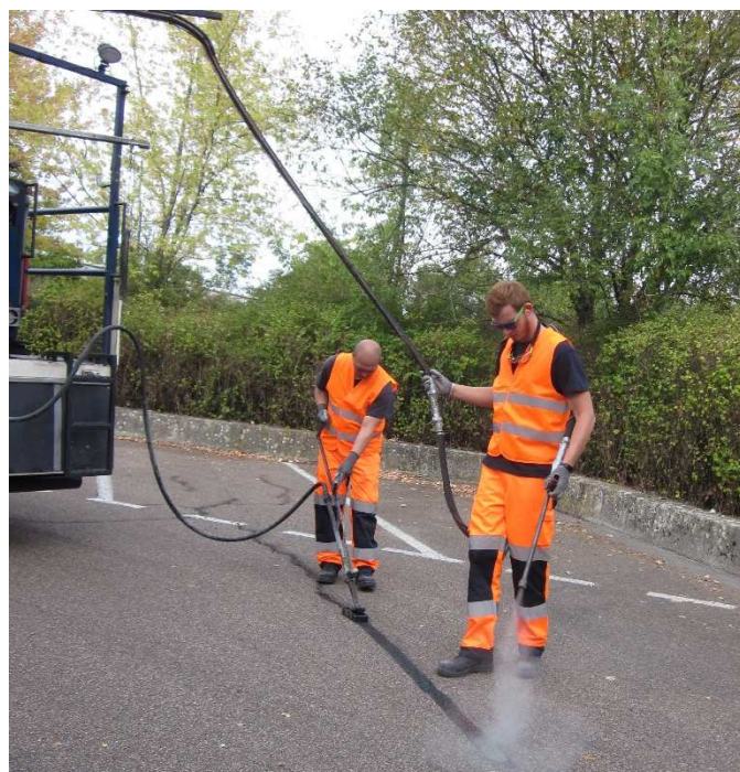
Opération de pontage en vue d'éviter la nécessité de désherber sur une aire d'autoroute
