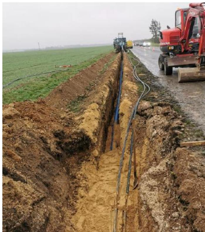
Travaux d'interconnexion d'Ozouer-le-Voulgis pose de la conduite AEP le long de la RD319
