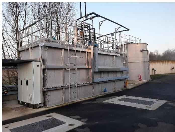
**Décanteur lamellaire (400 m<sup>3</sup>/h) pour traiter les by-pass sur la station d'épuration de Villeparisis/Mitry**
