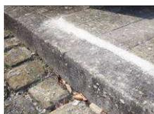
Pour éviter l'installation de la végétation non désirée à certains endroits, des travaux de réfection pourront être réalisés tels que la reprise des joints de trottoirs et caniveaux au mortier sur les zones creusées ou endommagées ou la rénovation des trottoirs les plus abîmés.
