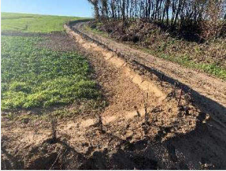
Merlon de terre
