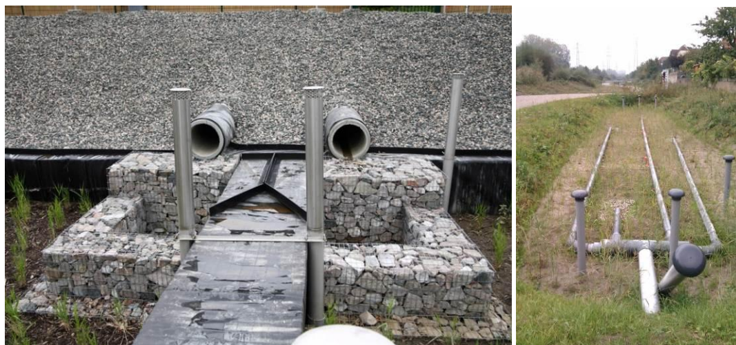
FIGURE 22 : REPRÉSENTATION DE DISPOSITIF D'ALIMENTATION POUR DE GROS DÉBITS AVEC GABION ANTI AFFOUILLEMENT (SITE DE MARCY L'ÉTOILE (69), GAUCHE) ET POUR DE FAIBLES DÉBITS (SITE D'OSTWALDDERGRABEN (67) , DROITE)
