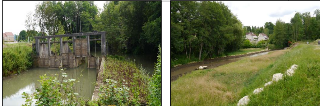
Vannage de St Rémy de la Vanne sur le Grand Morin
