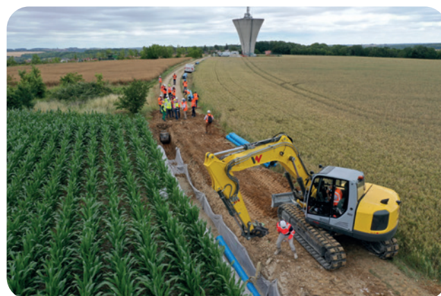
Travaux Transpr'Eauvinois - Ste Colombe - Longueville - © S2E77
