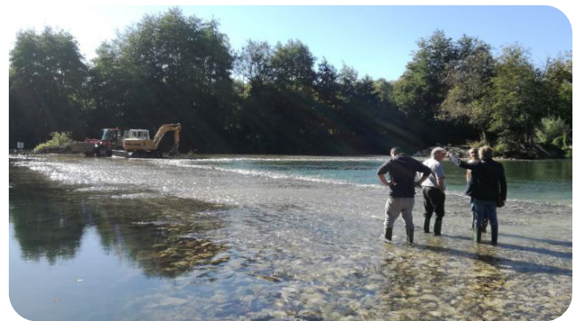
Travaux de restauration du Loing - © CD77
