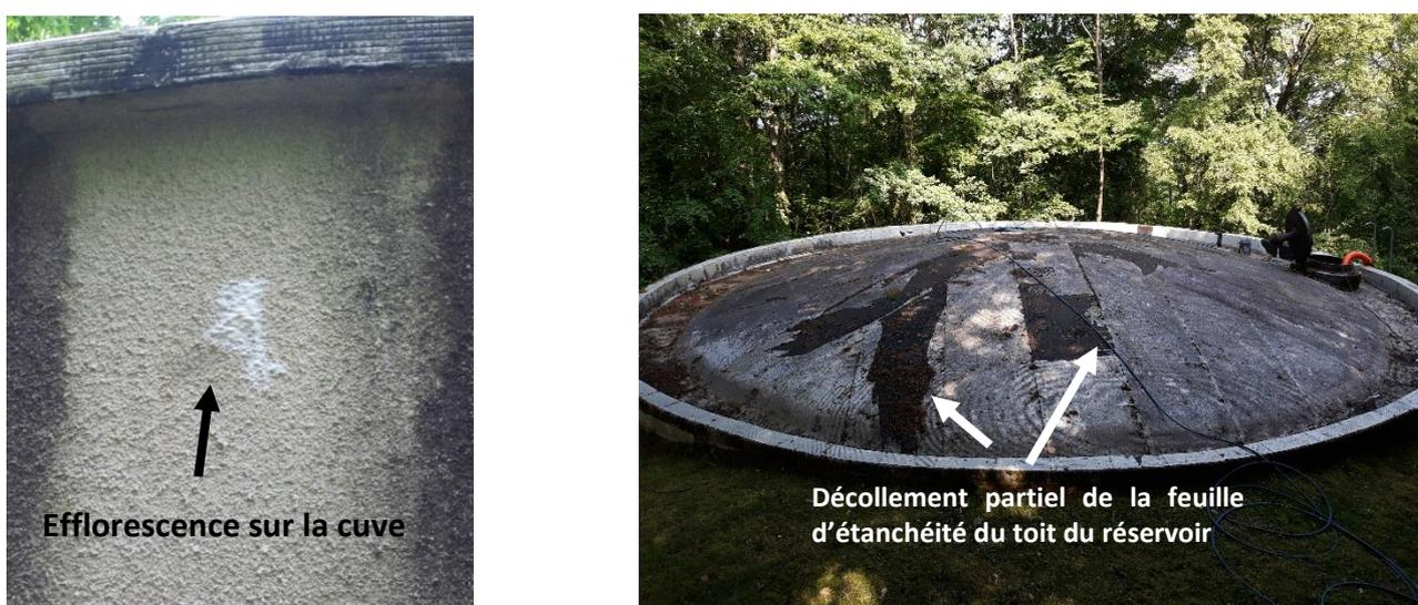
Figure 2: Exemples de désordres externes sur le réservoir de Treuzy-Levelay
