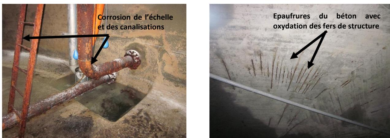
Figure 1 : Exemples de trace de corrosion et épaufrure du béton du réservoir de Treuzy-Levelay
