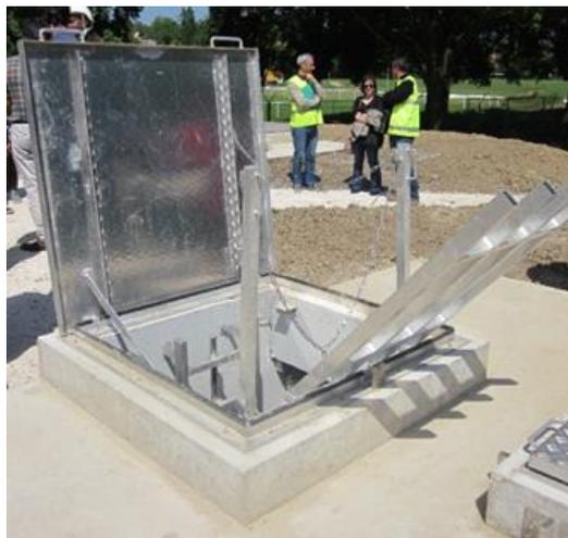
Trappe d'accès étanche sur margelle béton
