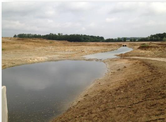
*1<sup>ère</sup> tranche : un chenal traversier provisoire été creusé à travers le fond de l'ancien bassin pour les besoins des écoulements hydrauliques.*
