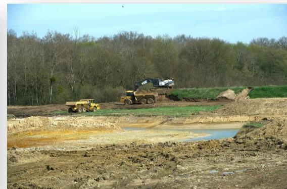
*Les déblais de terre du merlon au nord du site en rive gauche du ru des Hauldres sont réutilisés en remblais pour estomper les ouvrages de viaducs ferroviaires (2<sup>ème</sup> phase).*
