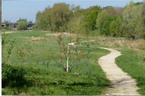
*Dans la partie centrale du parcours du ru, en rive gauche principalement, un réméandrage léger et une petite zone d'expansion de crue du ru ont été réalisés.*
