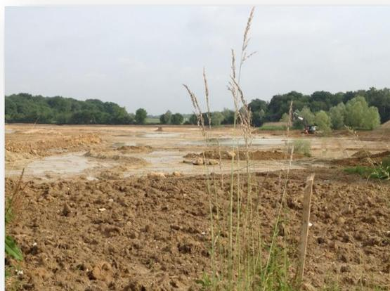
*Le remodelage de l'intérieur du bassin se dessine avec l'abaissement de la cote fini du terrain naturel (2<sup>ème</sup> phase).*
