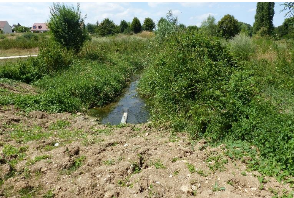
Bouchon terreux incitant le cours d'eau à reméandrer dans l'ancien étang et buse temporaire assurant un débit minimum dans l'ancien lit 19 juillet 2018
