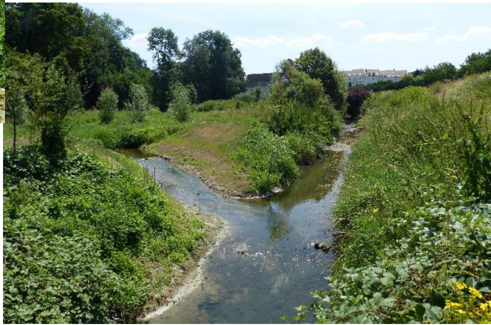
Reméandrage du cours d'eau dans l'étang amont et reprise des berges en technique végétal 19 juillet 2018
