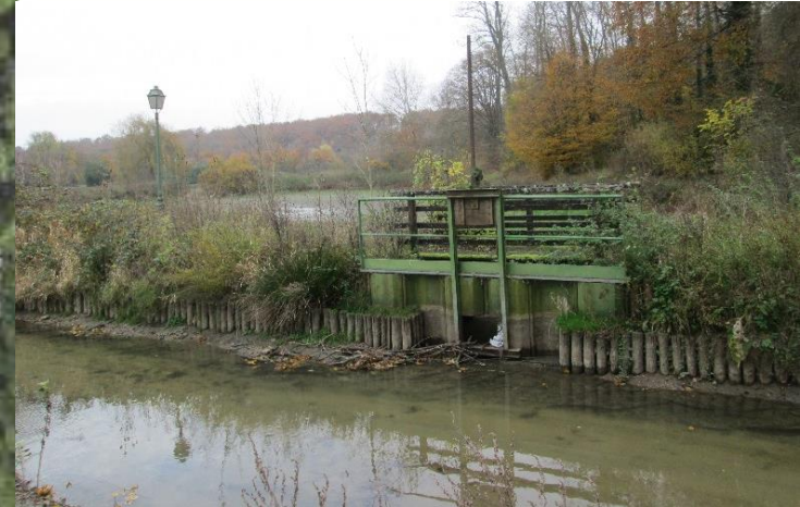
Vanne de l'étang amont 25 novembre 2014
