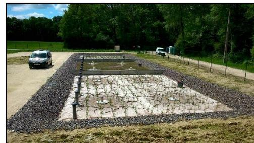
La configuration dite classique d'un filtre planté de roseaux est la solution la plus couramment rencontrée en France. Elle est composée de **deux étages de filtration à écoulement vertical (FPRv)**.
