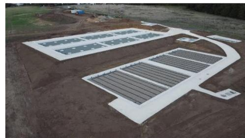
La surface des filtres est un des éléments clé du dimensionnement d'une station d'épuration FPRv. Les surface minimales des filtres sont calculées de la façon suivante :
