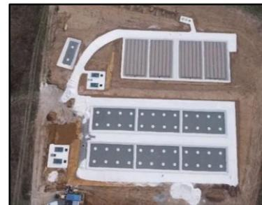
Chaque étage de filtration est décomposé en casiers permettant ainsi de respecter les phases d'alimentation et de repos :
