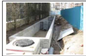
Dépollution par filtre à sable
