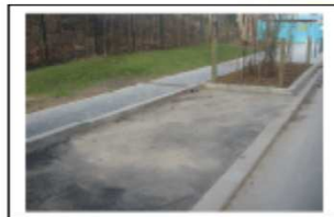
Ruissellement de voirie et parking vers bande verte (stockage/dépollution)
